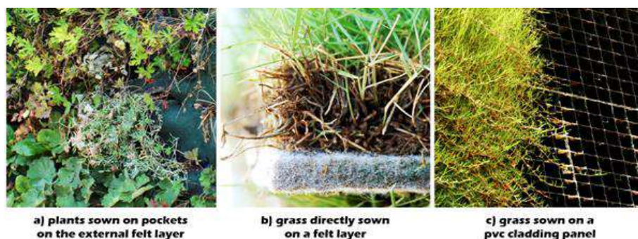
Vários métodos de fixação das plantas à estrutura de fachadas maiores (Mazzali et al., 2013)
